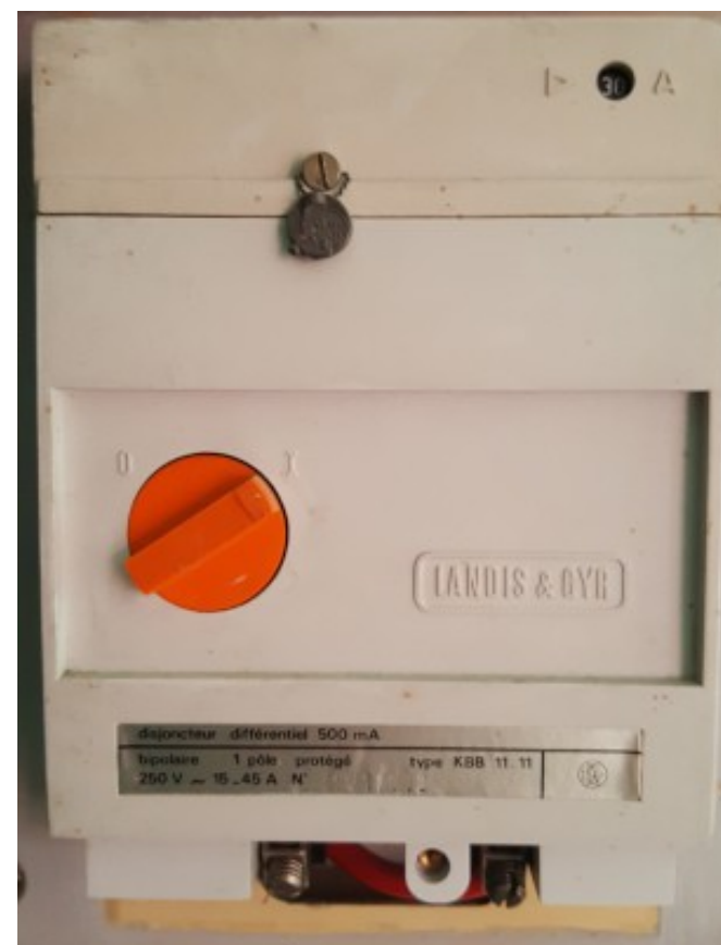
Ancien disjoncteur différentiel à 500 mA
