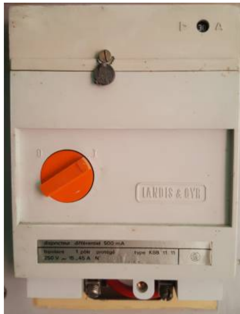
Ancien disjoncteur différentiel à 500 mA
